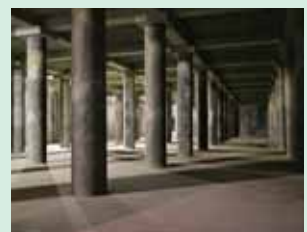
山王2号雨水調整池
