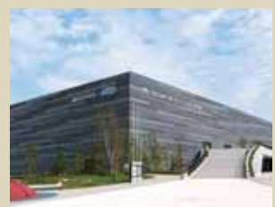
福岡市総合体育館
