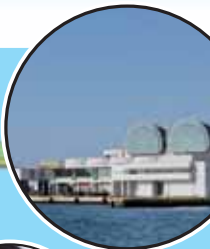
博多港国際ターミナル
