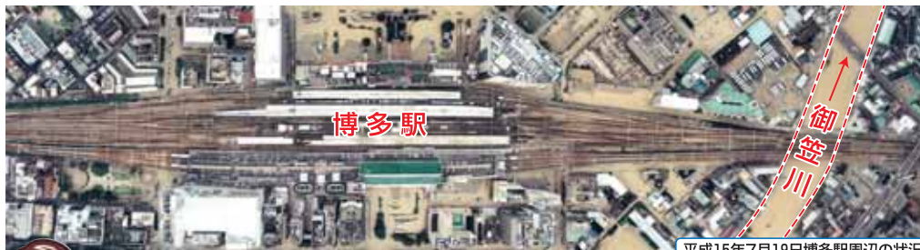
平成15年7月19日博多駅周辺の状況
