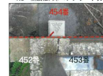
k8 新設福岡市コンクリート杭
