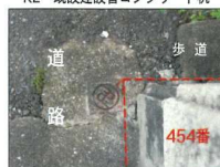
k2 既設建設省コンクリート杭
