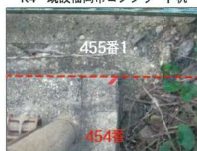
k4 既設福岡市コンクリート杭
