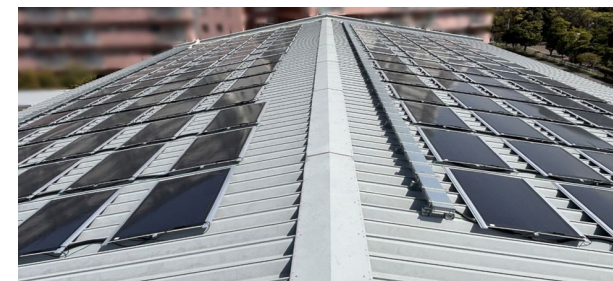
香椎浜小学校に設置しているペロブスカイト太陽電池
