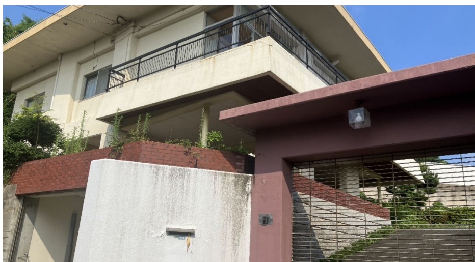
B 建物外観（西側 シャッターは電子式 通電後の使用可否不明）
