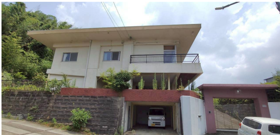
A 建物全景（北西側から）建物下部に堀車庫あり
