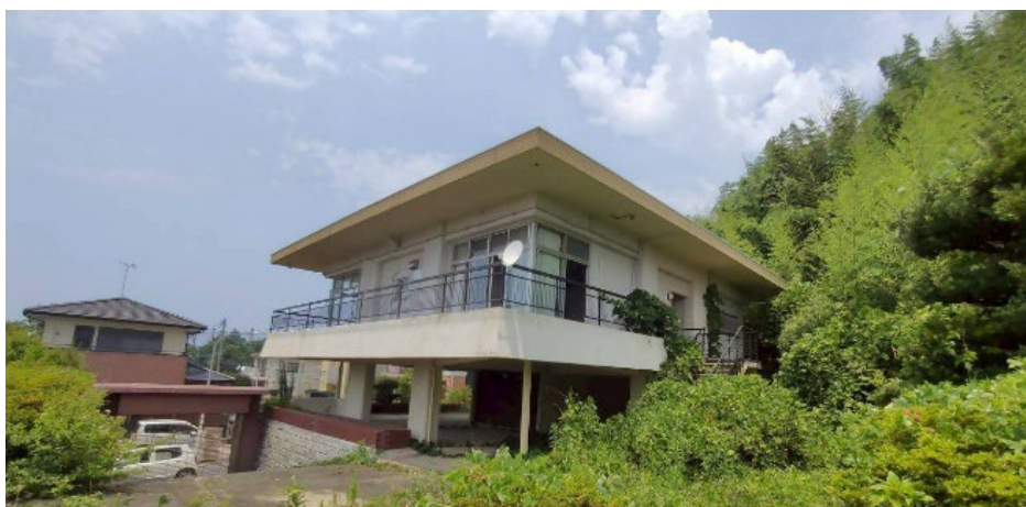
C 建物外観（南側から）
