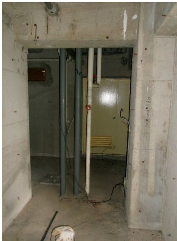
F 1階 元機械室
