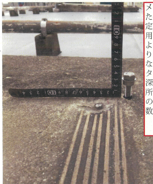
機器搬入・据付工事（室外機据付） 室外機据付用アンカーボルト ケミカルアンカー用 アンカーボルト挿入 挿入長さ130mm-40mm=90mm （挿入長さ80mm以上）OK
