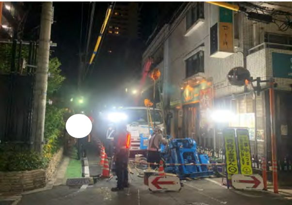
人通りの多い狭隘道路での施工
