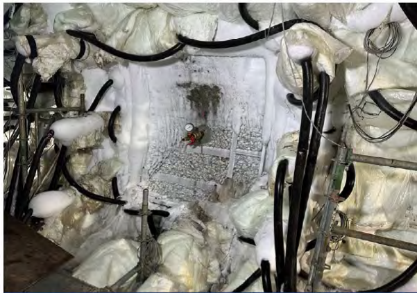
本市施工実績が極めて少ない凍結工法
