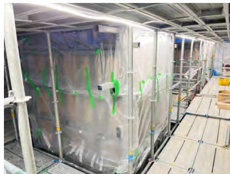
寒中コンクリート対策措置 (打設部全面シート養生)
