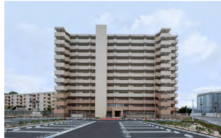
建物全景：北面
