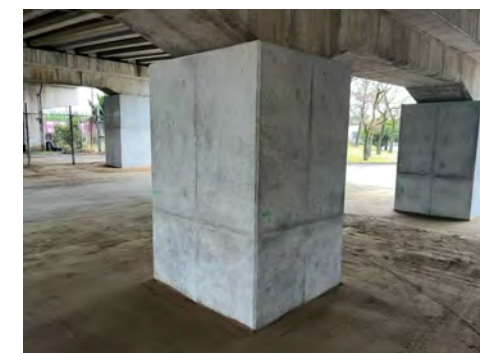
橋脚補強工
