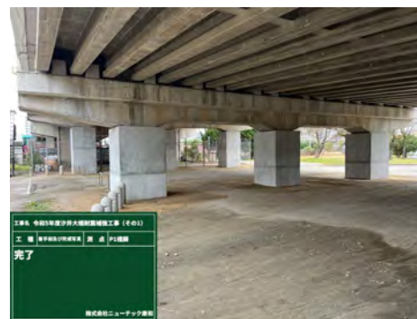
耐震補強工(工事完成)
