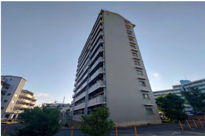
建物全景：東面
