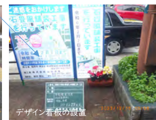
デザイン看板の設置
