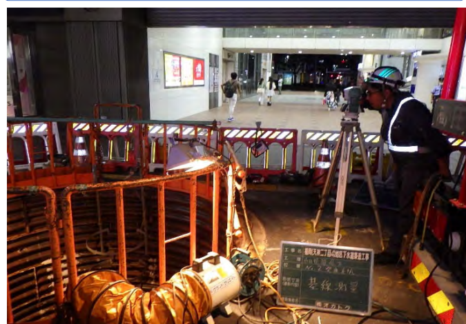
人通りの多い場所での施工（発進立坑）
