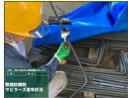
鉄筋保管時の腐食抑制処理
