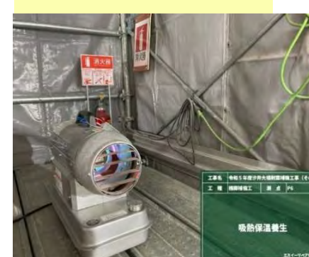
冬期のコンクリート養生
