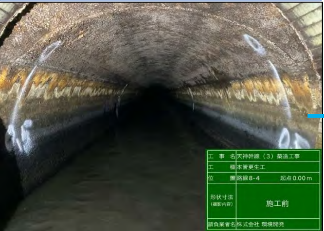
下水道管内写真（管更生前）
