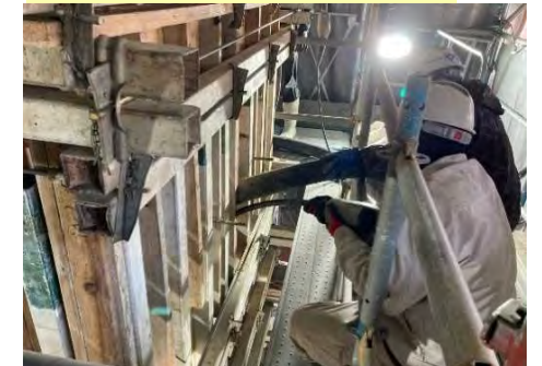
打継目を設けない打設方法
