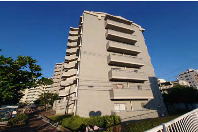
建物全景：西面
