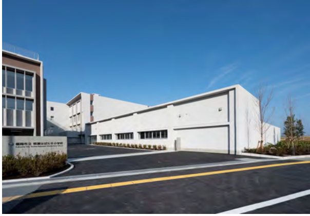
プール棟西側外観
