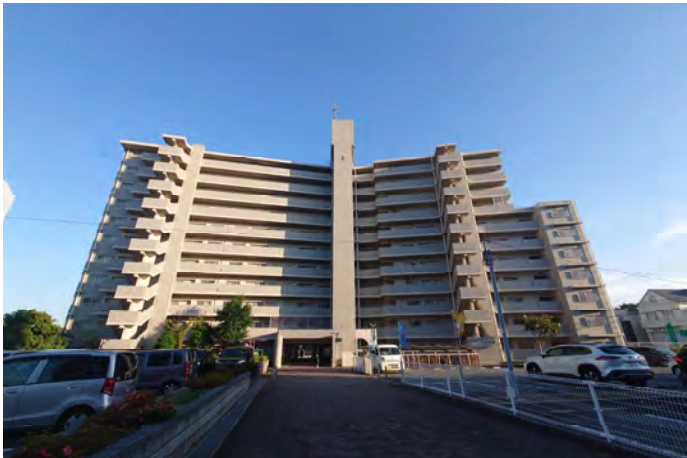
建物全景：北面
