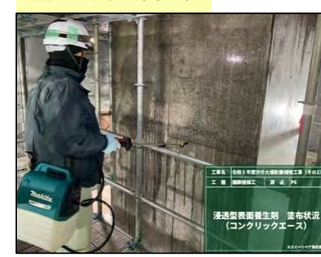
浸透型養生剤散布
