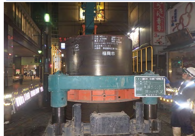
人通りの多い場所での施工（到達立坑）
