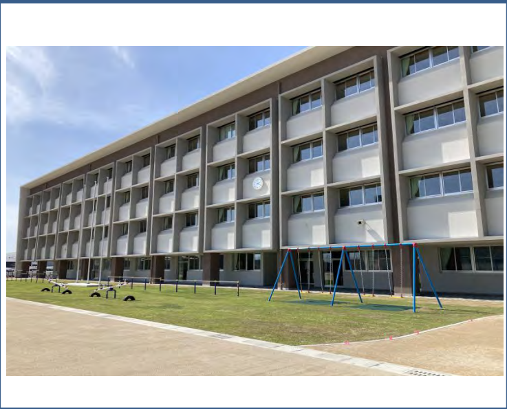
● 【アイランドシティ地区小学校 全景】
