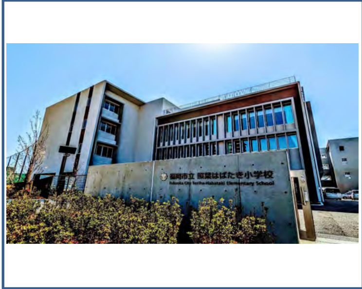
● 【アイランドシティ地区小学校 全景】
