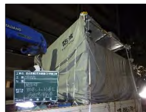
防音シートによる養生
