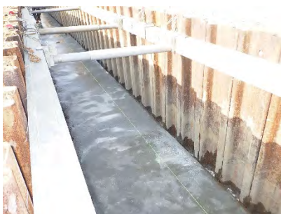
① ヒューム管の沈下対策
