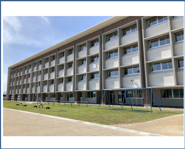
● 【アイランドシティ地区小学校 全景】
