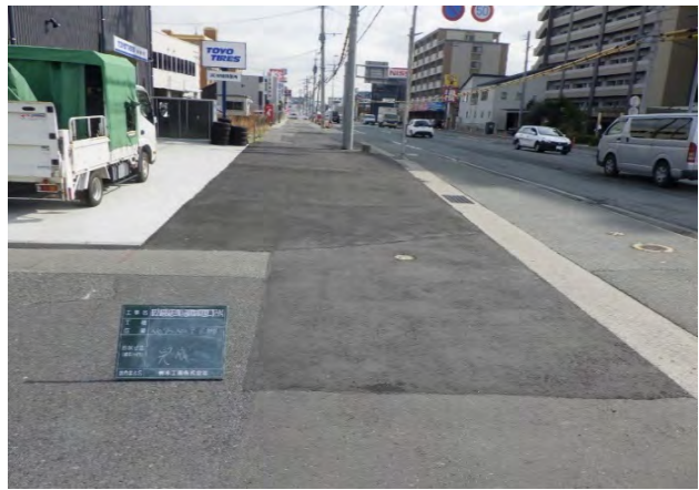
完成(路線東側)
