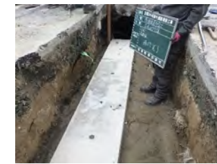
基礎コンクリート版
