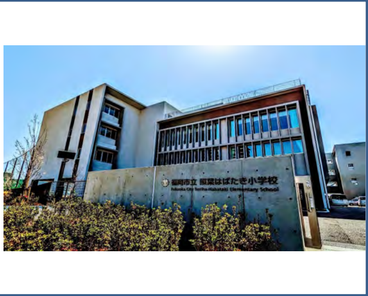
● 【アイランドシティ地区小学校 全景】
