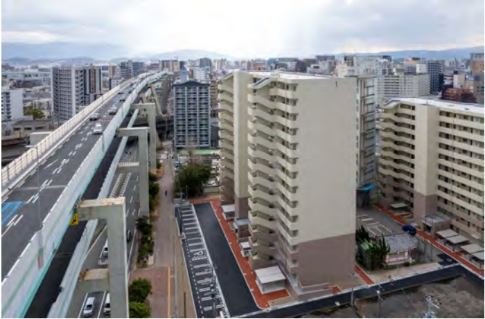
建物全景:北西面
