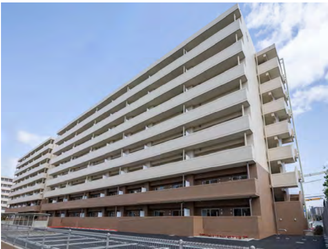
建物全景:西面
