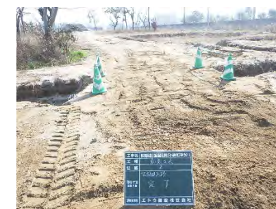
⑤ 現地視察の通路整備
