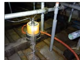
充填剤注入前ポンプ使用状況
