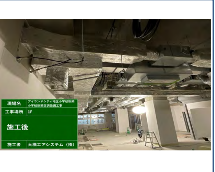
● 【給食室換気ダクト 完成】
