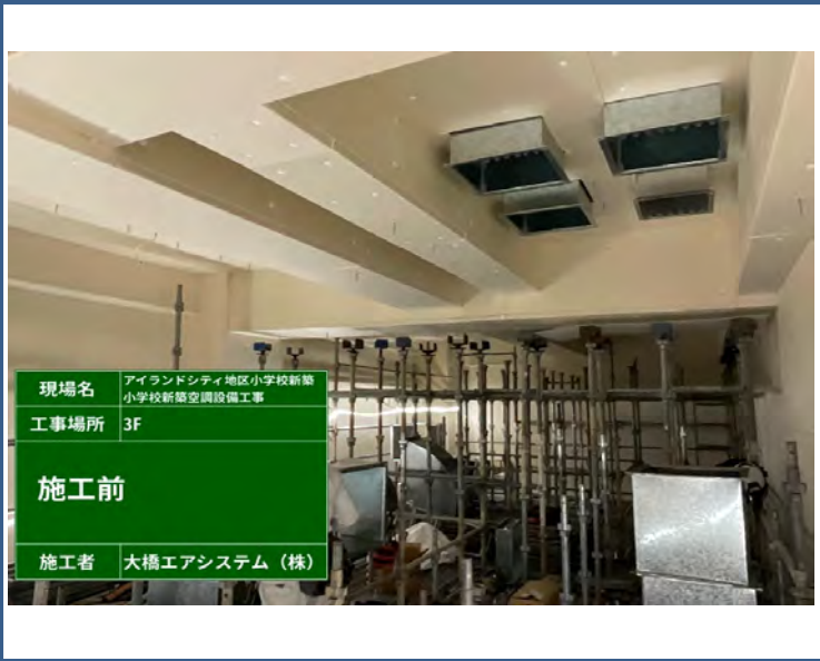
● 【講堂兼体育館換気設備 着手前】
