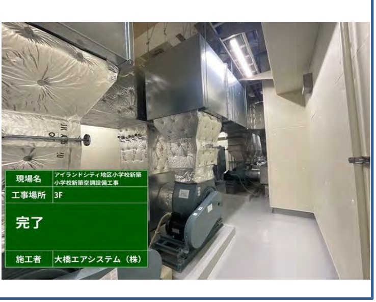
● 【講堂兼体育館換気設備 完成】
