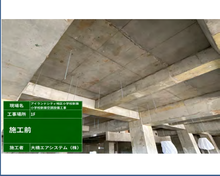
● 【給食室換気ダクト 着手前】
