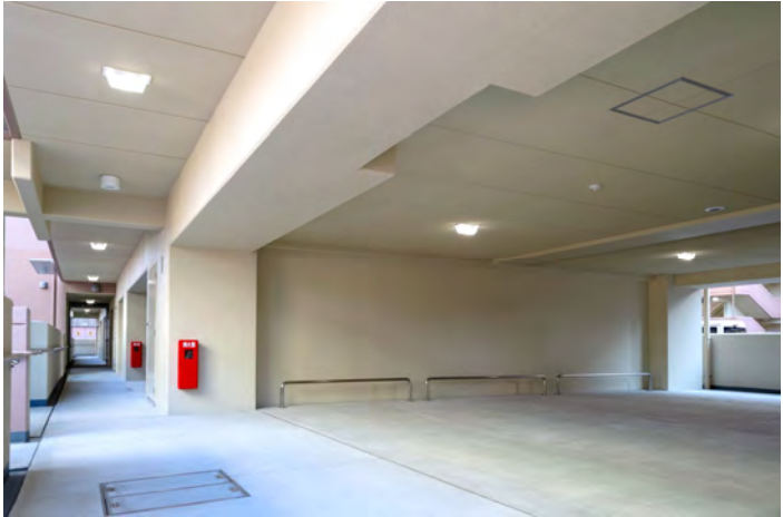
1階棟内駐輪場
