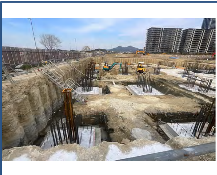
● 【埋設管 着手前】
