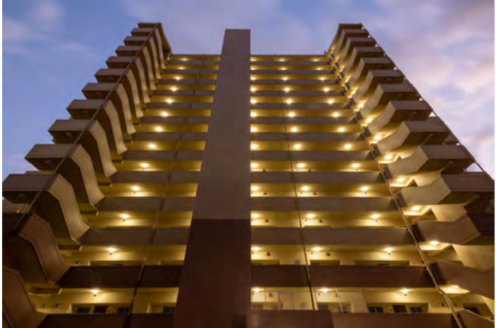
建物全景:北面
