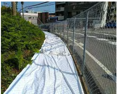
防炎シート設置による 臭気対策の実施
