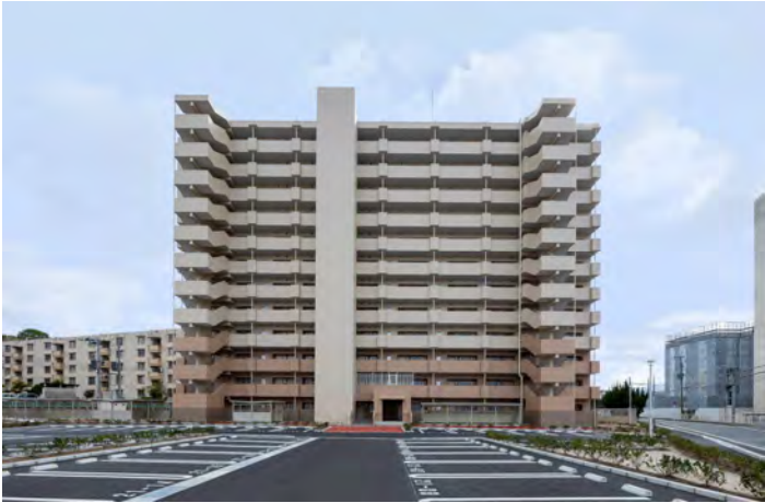
建物全景:北面
