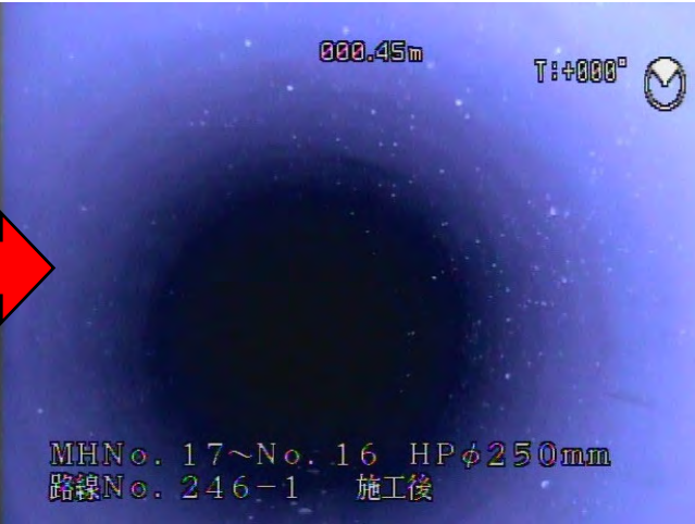
完成（管更生後）
