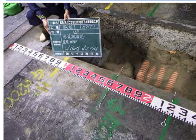
地下埋設物の状況を確認
