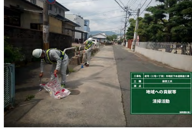
工事周辺の清掃を実施
