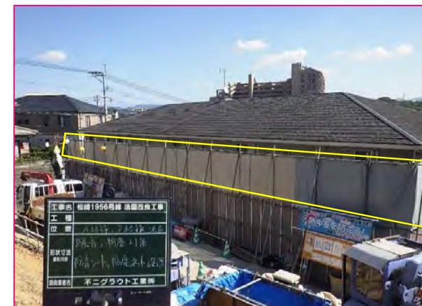
① 防音シート設置・防塵ネット(隣接アパート)
