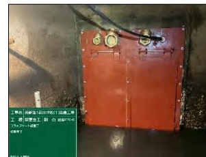
フラップゲートの設置
