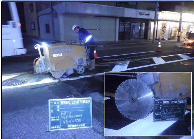
消音カッターの使用
