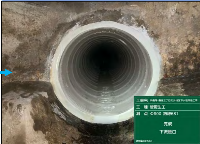
下水道管内写真（管更生後）
