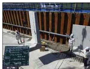
L型擁壁設置状況
