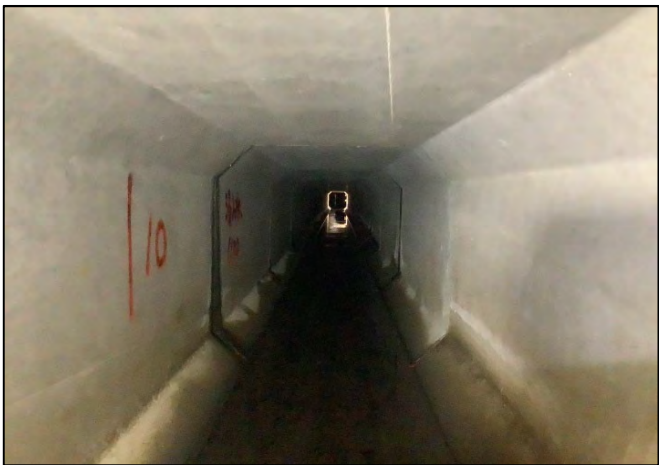
下水道管内写真（管更生前）
