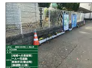
プランターの設置
