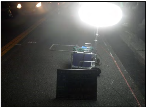
①作業用照明の工夫
