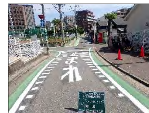
現場周辺の区画線再設置
