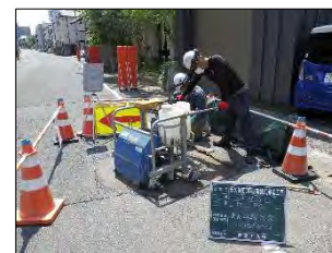
GMR工法施工状況
