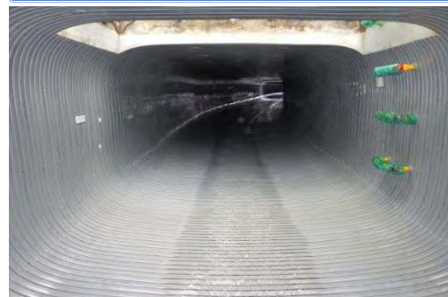
○管更生工（製管完了）
