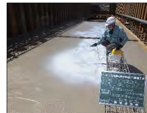
コンクリート打継処理剤の散布状況
