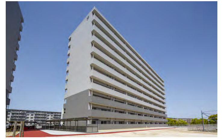
建物全景:南西面
