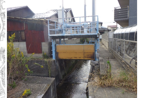
④室見第2雨水幹線・用水路伏越し部
