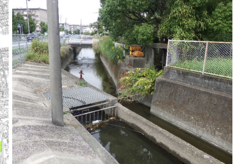
⑤西田隈第1雨水幹線・用水路並走部
