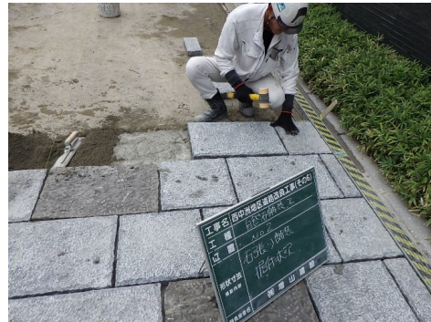
石畳設置状況
