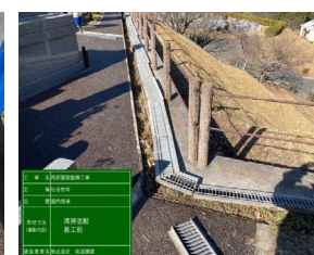
工事範囲外の清掃
