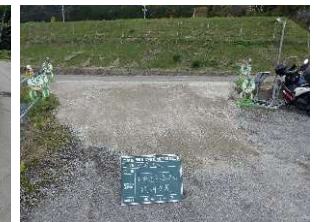
仮駐車場の設置
