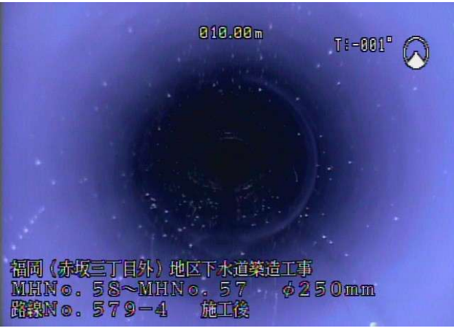
下水道管内写真（管更生後）
