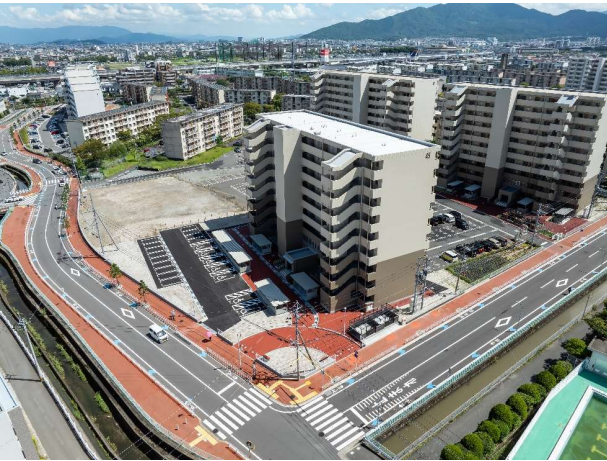
建物全景:空撮写真
