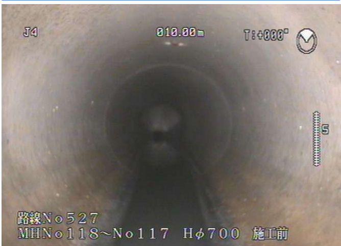
下水道管内写真（管更生前）
