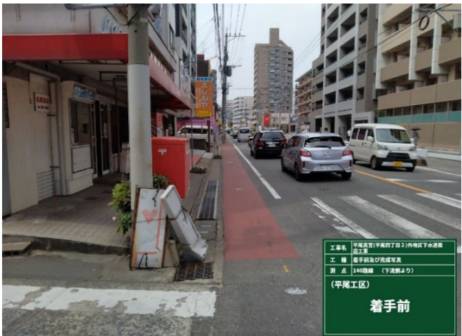
側溝整備 着手前 （平尾工区）
