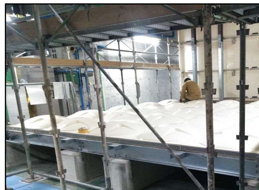
受水槽組立状況
