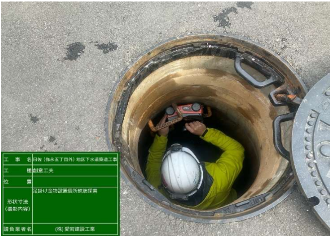
コンクリート内部探査用電磁波レーダーの使用
