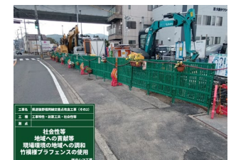
プランターの設置
