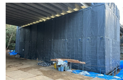
⑥騒音対策のため防音シートの設置
