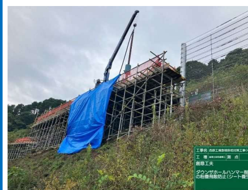
削孔時の粉塵対策
