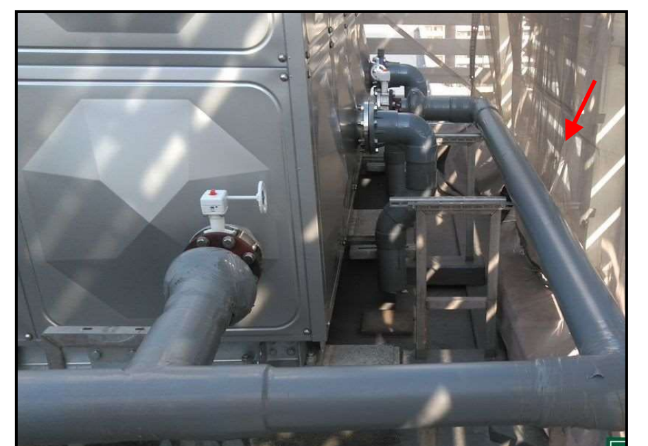
仮説配管施工状況
