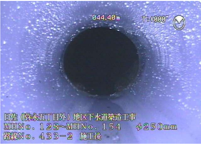
下水道管内写真（管更生後）
