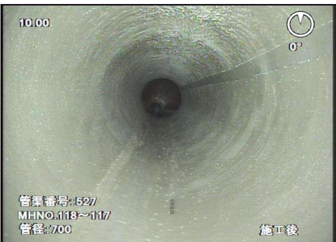
下水道管内写真（管更生後）
