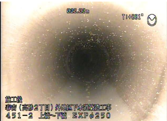
下水道管内写真（管更生後）
