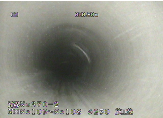
下水道管内写真（管更生後）
