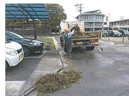
大雨後の道路清掃
