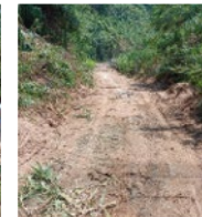
土砂撤去完了
