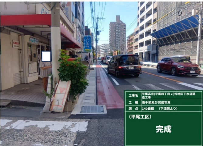
側溝整備 完成 （平尾工区）
