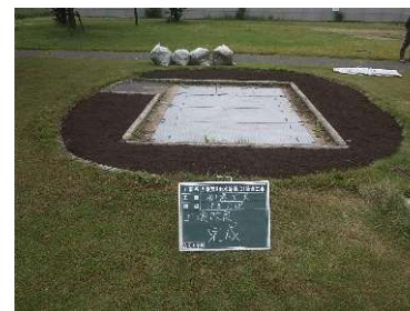
津屋公園植栽土壌改良
