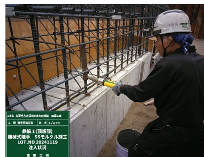
モルタル充填式鉄筋継手
