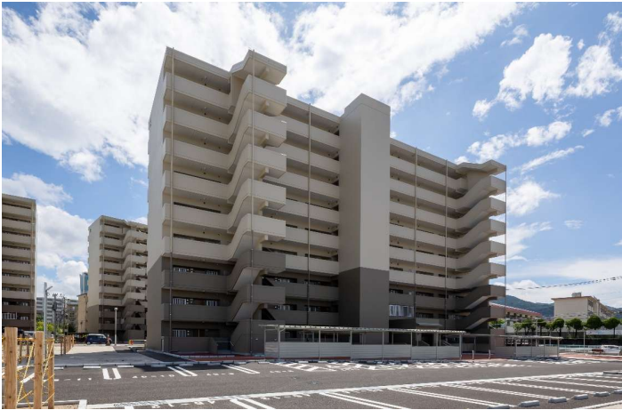
建物全景:外観北面
