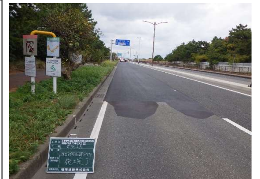
③施工端部における 段差の解消
