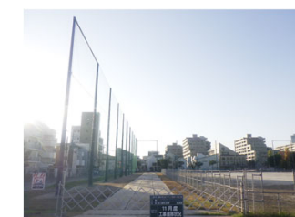
強固な仮設フェンス設置
