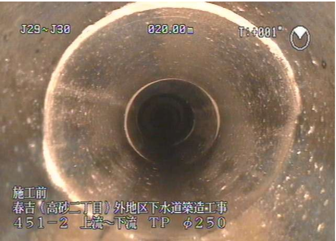
下水道管内写真（管更生前）
