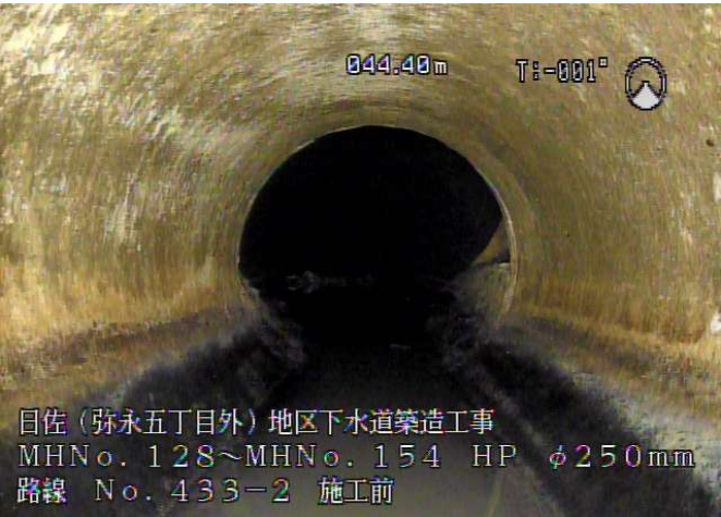
下水道管内写真（管更生前）
