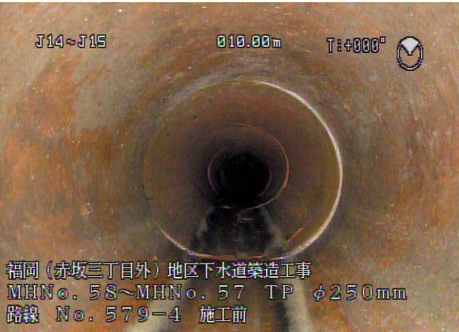
下水道管内写真（管更生前）
