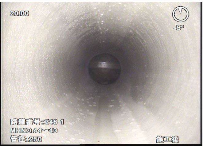
下水道管内写真（管更生後）
