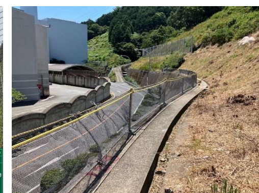
飛来・落下防止ネットの設置
