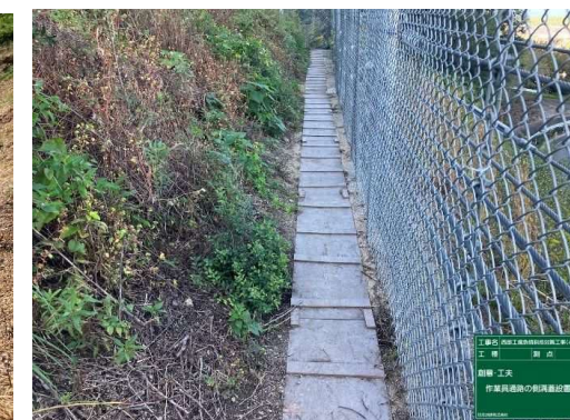
通路部の仮設側溝蓋設置
