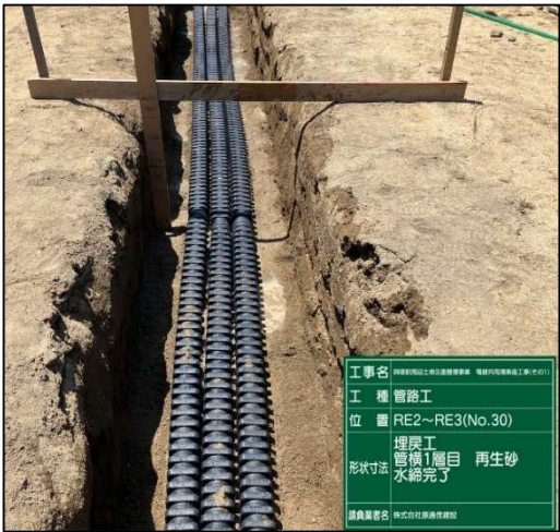
管路敷設写真
