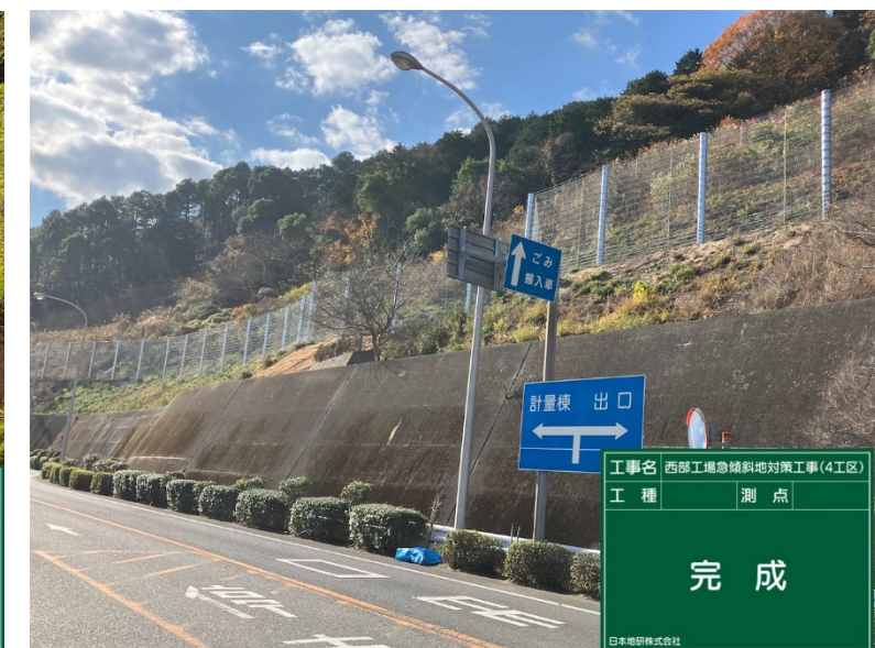
完 成（崩壊土砂防護柵設置）
