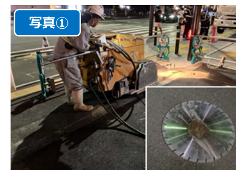
▲舗装切断時の消音ブレード
