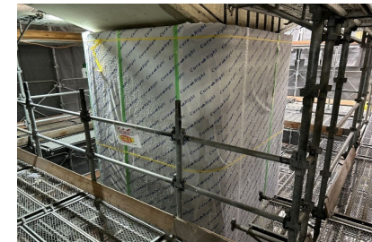
④ひび割れ抑制剤塗布による保護
