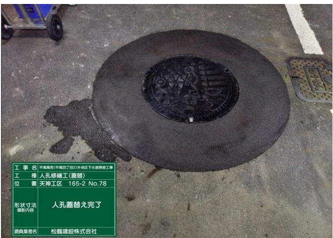
施工方法の工夫（GMラウンド工法）
