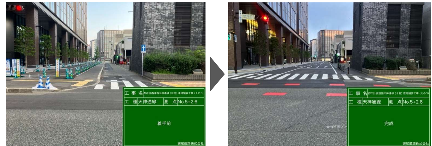
▲着手前（車道1車線） ※一方通行
