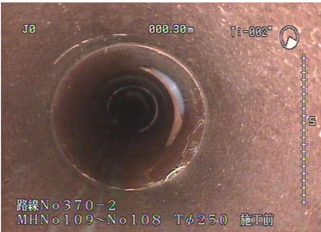
下水道管内写真（管更生前）
