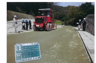
ICT建設施工説明会（舗装）
