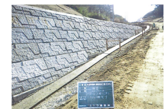
実施：大型ブロック
