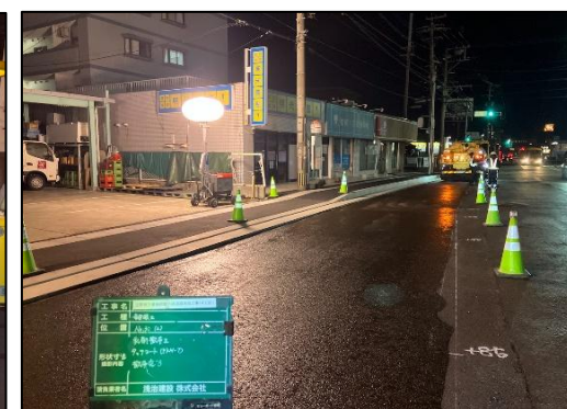
②排水性アスファルト乳剤（ファームゾール）の使用
