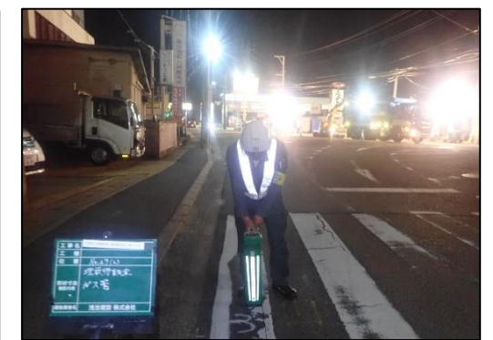
④埋設管の計測
