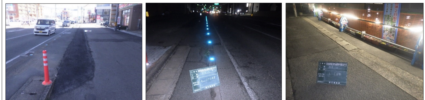
舗装補修・擦り付け
