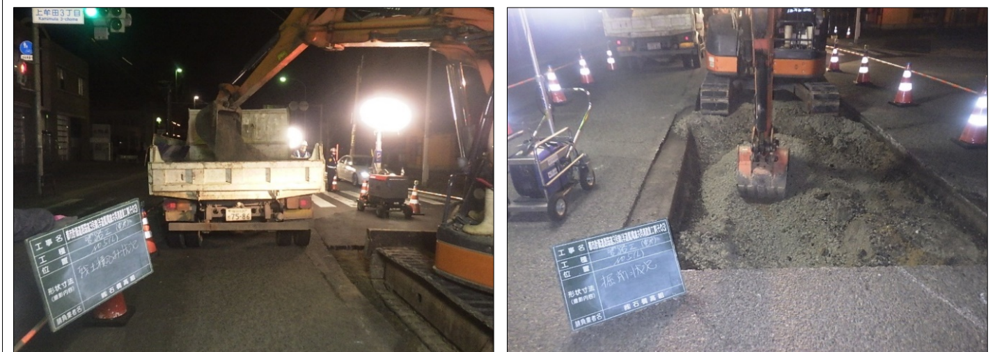
夜間施工(交差点内)
