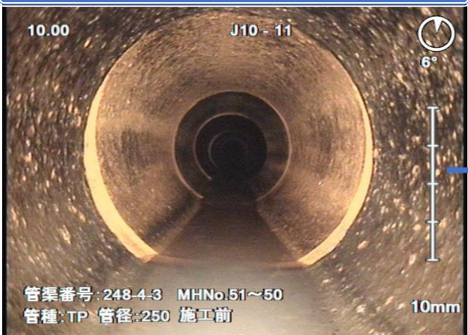
下水道管内写真（管更生前）
