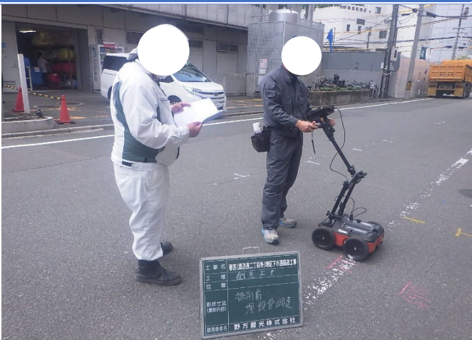
地下埋設管探査レーダーの使用
