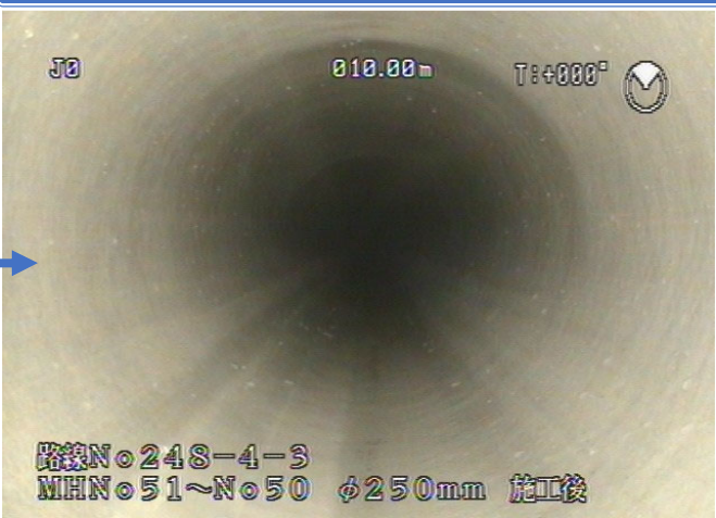
下水道管内写真（管更生後）
