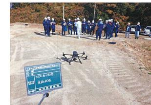
ドローンによる3次元起工測量
