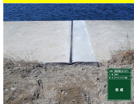
消波ブロック護岸目地補修
