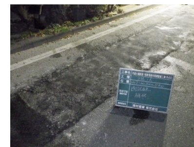
地域貢献（舗装補修）
