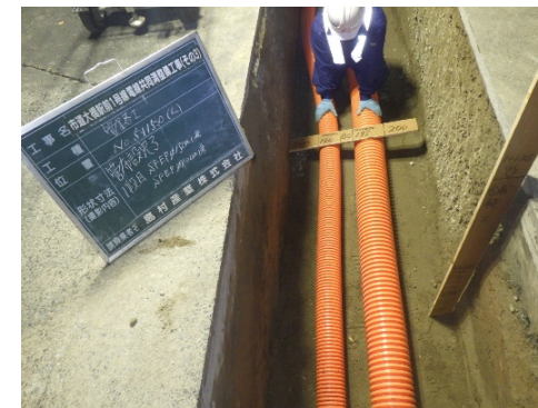
②管路工施工状況
