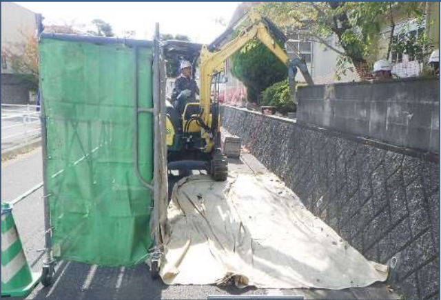
既設コンクリートブロック塀撤去状況
