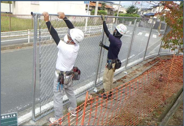
ネットフェンス設置状況
