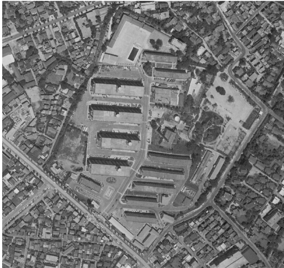
防衛庁本庁檜町庁舎及び防衛施設庁庁舎
