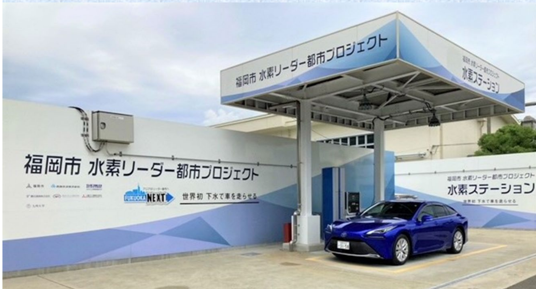
福岡市水素ステーション（中部水処理センター内）
