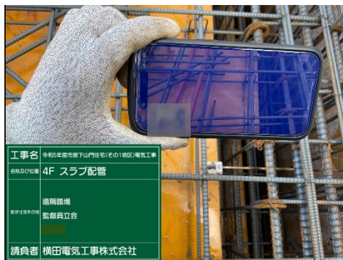
【立会状況②（配管確認）】
