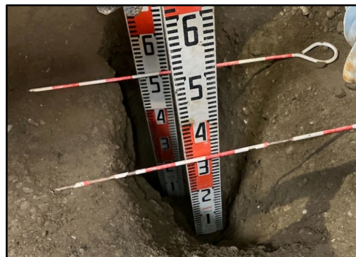
【立会状況（路盤出来形確認）】
