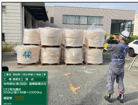
【立会状況①（材料確認）】
