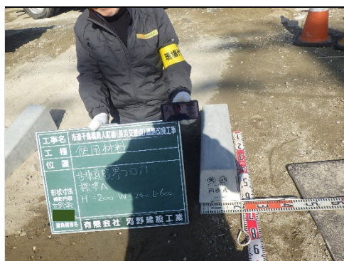
【立会状況（材料確認）】
