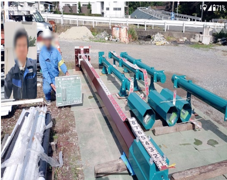
【立会状況（材料確認）】
