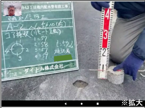
【立会状況（コア厚み確認）】
