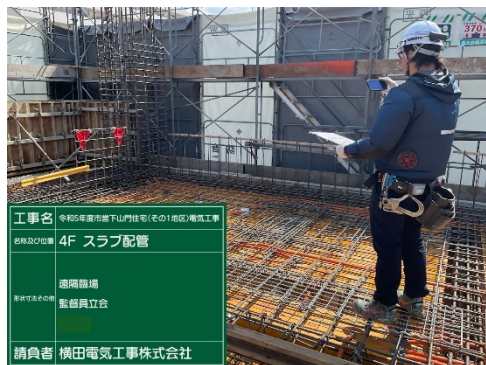
【立会状況①（配管確認）】
