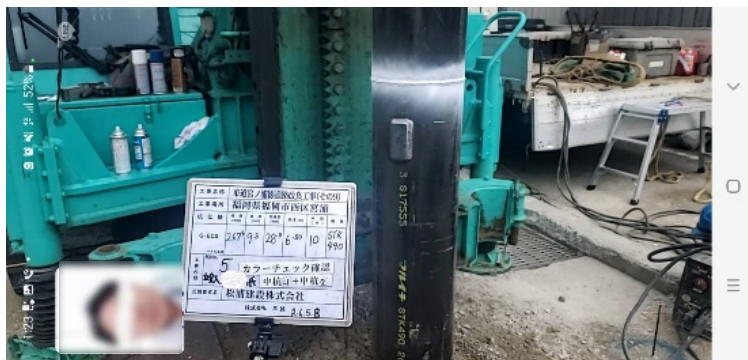
【立会状況（カラーチェック）】
