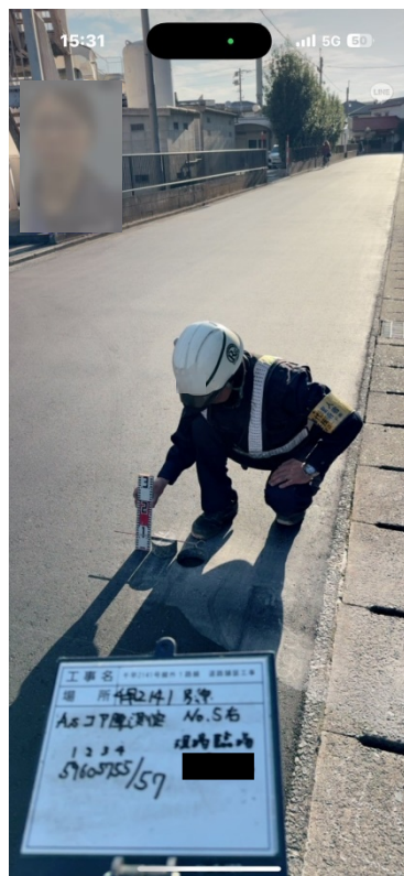
【立会状況（舗装厚確認）】
