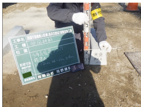
【立会状況（材料確認）】
