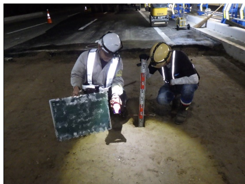
【立会状況（路盤厚確認）】
