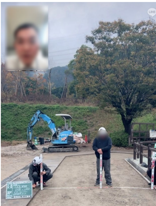
【立会状況（路盤確認）】
