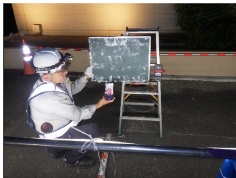
【立会状況（LED照度確認）※技術提案】
