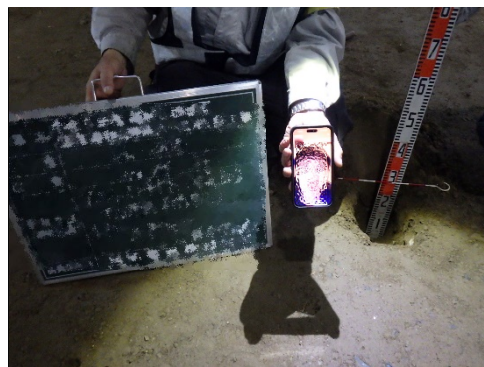
【立会状況（路盤厚確認；近接）】
