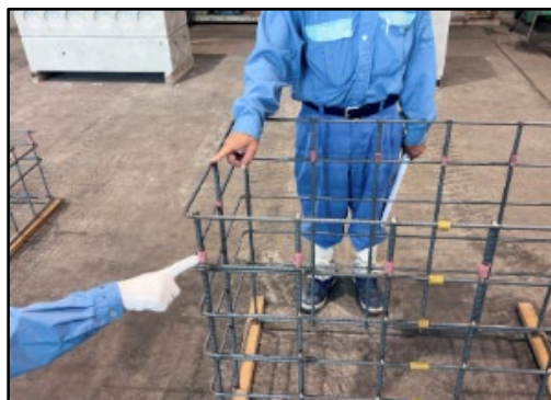
【立会状況（配筋確認）】
