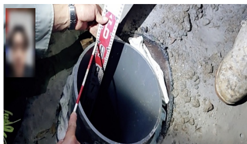
【立会状況(取付管推進工の出来形確認)】
