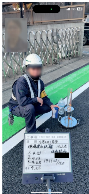
【立会状況（現場透水試験）】
