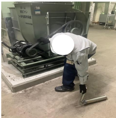
①送風機カバーを外し、後方のグリスガンを取ろうとした。
