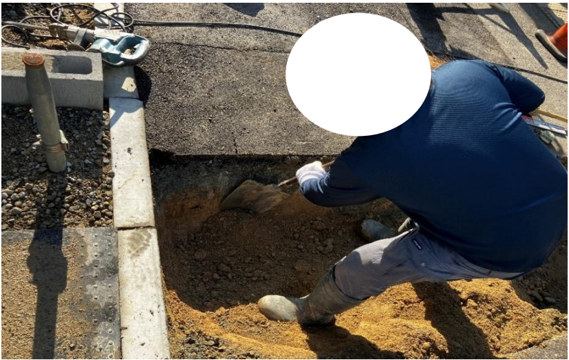
掘削時の埋設物付近手掘り状況
