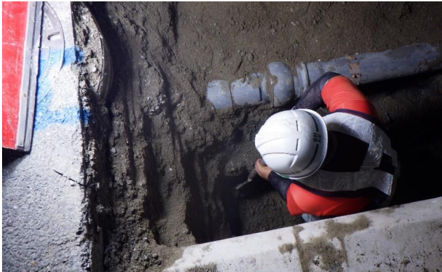
掘削時の埋設物付近手掘り状況
