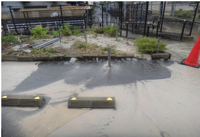
打込み単管施工中、漏水発生状況
