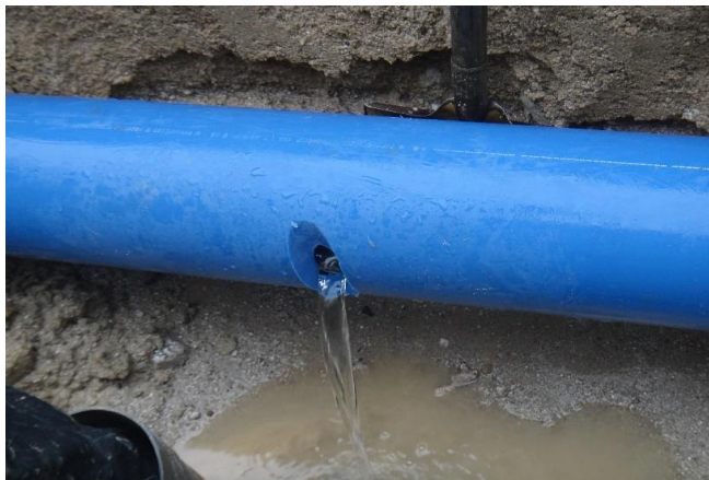
埋設給水管破損状況
