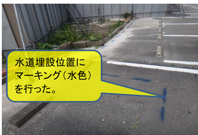
現地にての埋設配管経路確認の実施状況
