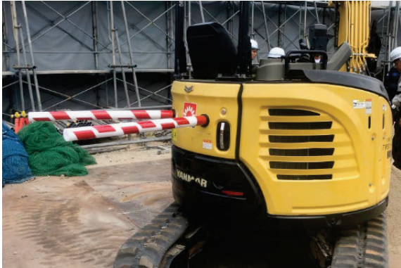
赤白棒による機械後方の立入禁止
