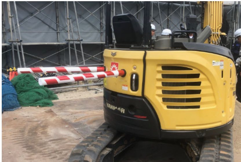
赤白棒による機械後方の立入禁止
