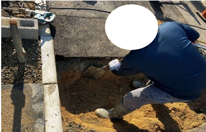
掘削時の埋設物付近手掘り状況
