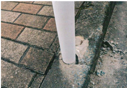
フェンス基礎破損箇所
