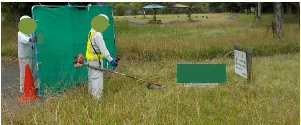
飛散防止ネット設置の徹底。飛散の少ない刈払機の使用を実施。
