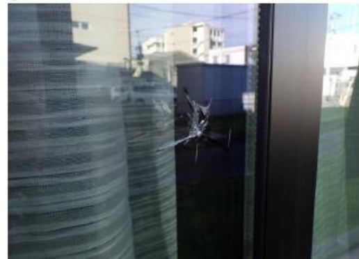
破損した窓ガラスの状況
