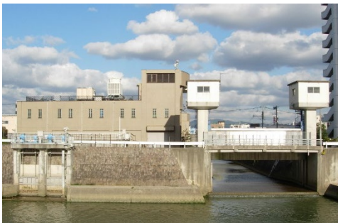
例：上牟田川排水機場
