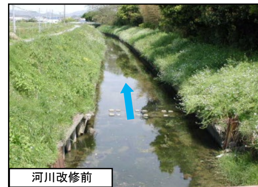
都市基盤河川改修事業（周船寺川）
