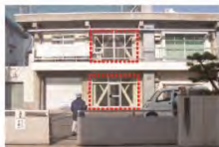
耐震化の事例 (ブレース設置)
