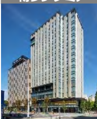
3 九勸 承天寺通りビル
