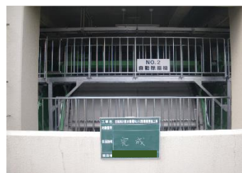
更新完了後(排水機場除塵機)
