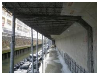
補修中（劣化部のはつり）
