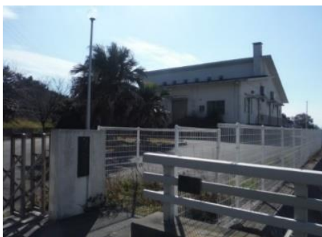
■ 西浦集落排水処理場
