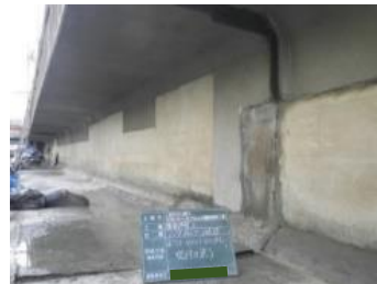
補修完了（断面修復）
