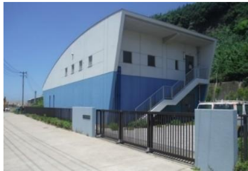
■ 小呂島集落排水処理場
