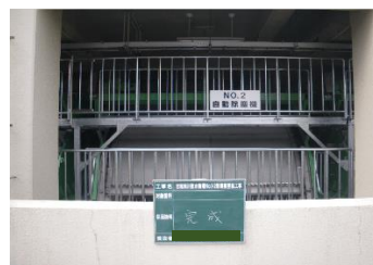
更新完了後(排水機場除塵機)
