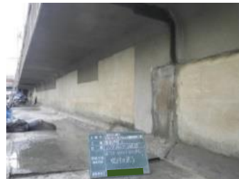
補修完了（断面修復）
