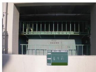
更新前(排水機場除塵機)
