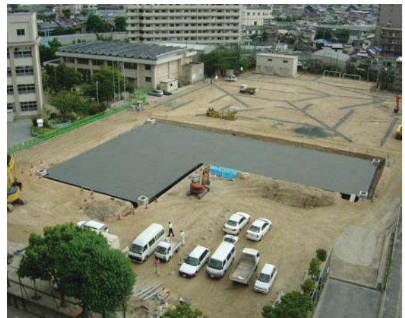
写真 板付北小学校雨水調整池設置状況
