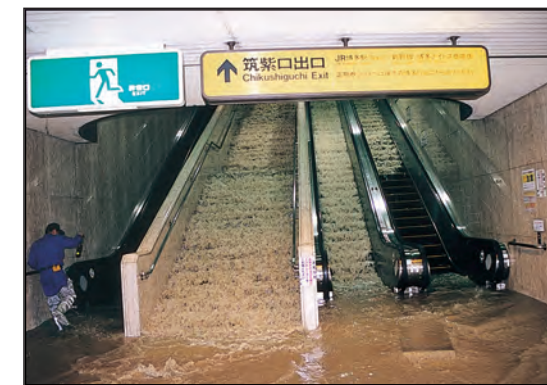
大雨で水浸しになった博多駅周辺
