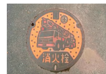
地中にうめられている消火栓
