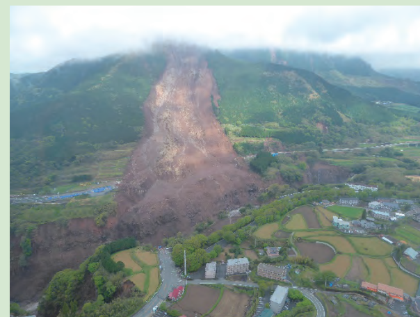
阿蘇大橋の崩落現場
