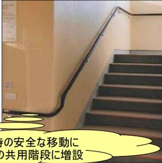
日常的な利用に限らず、災害時の安全な移動に必要な手すりを既設市営住宅の共用階段に増設
