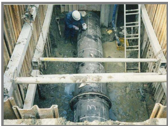
管体調査状況
