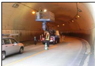
トンネル点検状況
