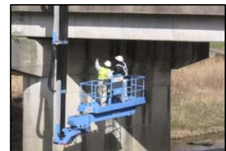
橋梁点検状況
