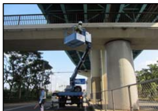
横断歩道橋点検状況
