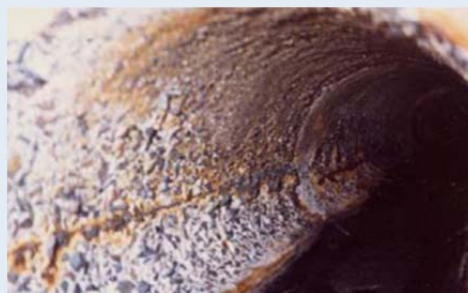
写真 老朽化した下水道管内の状況
