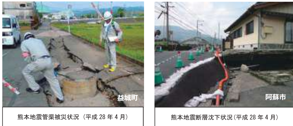
図 2.2.4 熊本地震による被害状況
