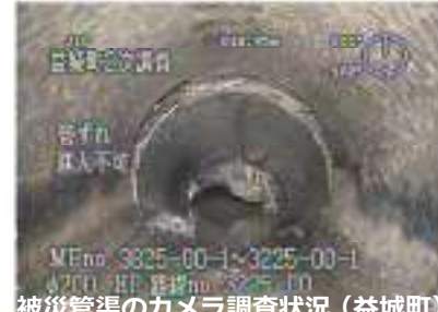
被災管渠のカメラ調査状況(益城町)
