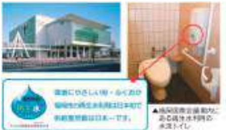
トイレの洗浄水利用
