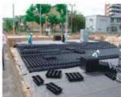
板付北小学校雨水調整池設置状況（地下貯留式 約 800m 3 ）
