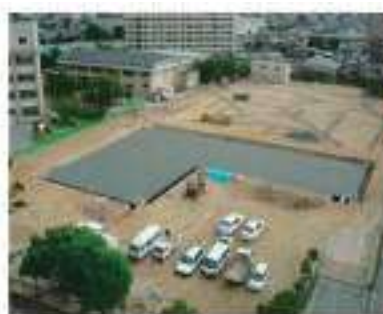
板付北小学校雨水調整池設置状況（地下貯留式 約 800m 3 ）
