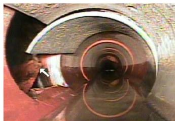
写真-1 老朽化により破損した管渠
